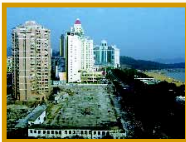
海天花園建築地盤
